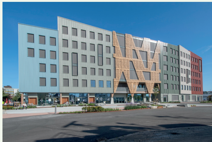
Fasadene i det nye bygget er brutt opp med fargerike flater, noe som spiller på resten av den mangefagede havnefronten i Kristiansund.
