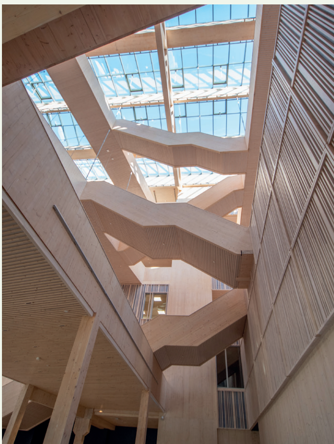
Bæresystemet i limtre og massivtre vises godt frem i hele bygget.
